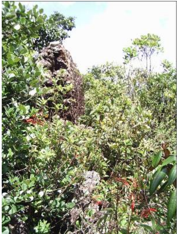
Foto 12 - Aspecto da parede norte, único segmento com altura total preservada.
