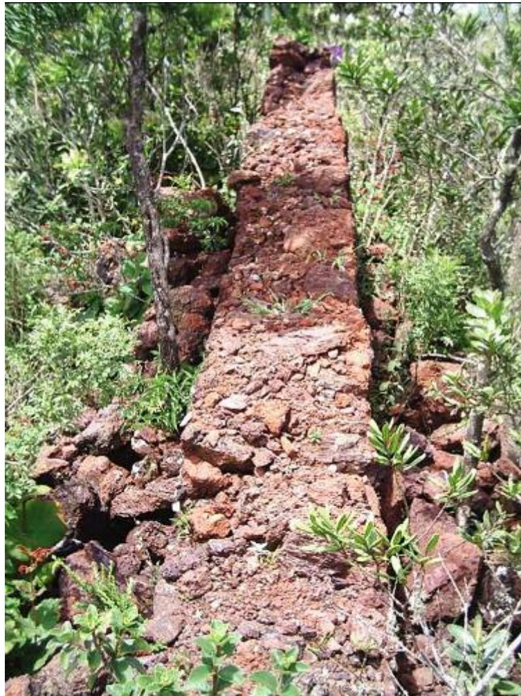
Foto 10 - Parede oeste em franca demolição.
