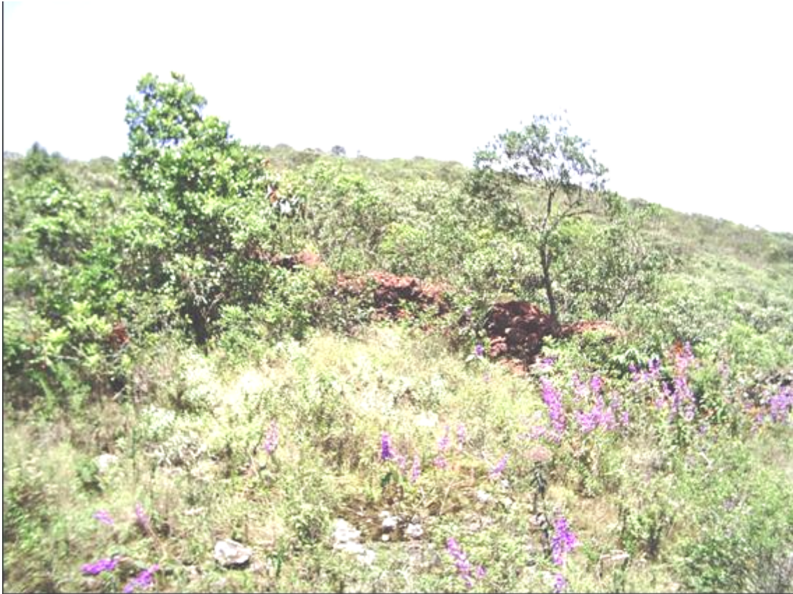
Foto 4 - Curral de Pedras: vista parcial dos resquícios da parede sul.
