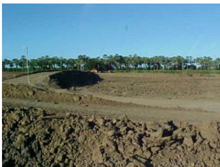
Fig. 5. Viveiro em construção.
